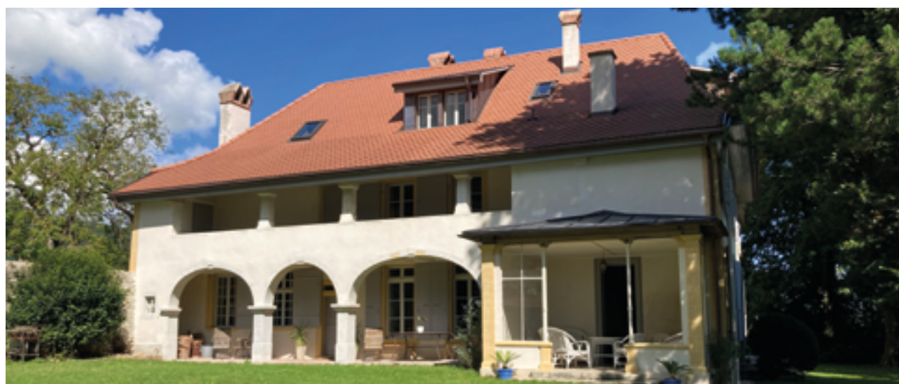
La galerie ouest datant du début du XVIII e siècle s'ouvre sur le parc.
