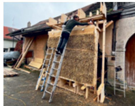
Préparation et compression des murs porteurs en paille. DR
