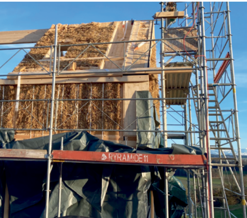
Mur porteur en paille et isolation du toit et du sol en paille également. DR
