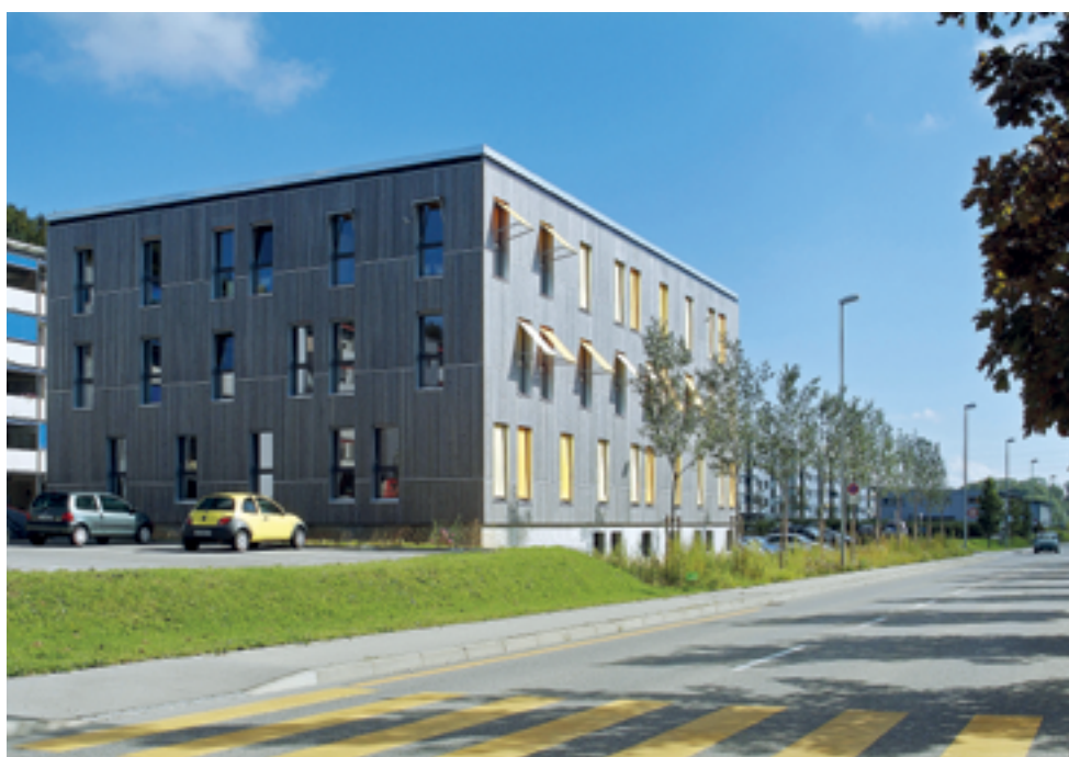
Le bâtiment administratif de Lutz Architectes à Givisiez ne nécessite aucun raccordement au réseau d'eau (hormis pour l'évier de la cuisine). Lutz Architectes
