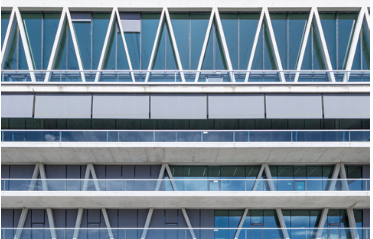
Au quatrième étage et au rez-de-chaussée, les vitrages, dépourvus de châssis, sont stabilisés par des lames en verre.
