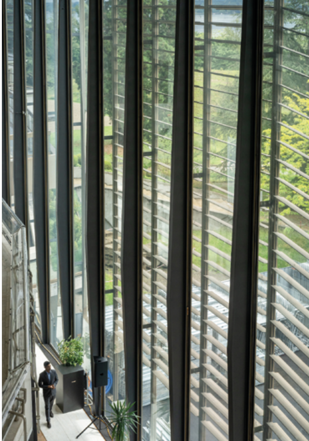
La façade vitrée du bâtiment E sera entièrement démontée et tous les panneaux de verre seront changés. Chaque élément vitré mesure 14 mètres de haut.
