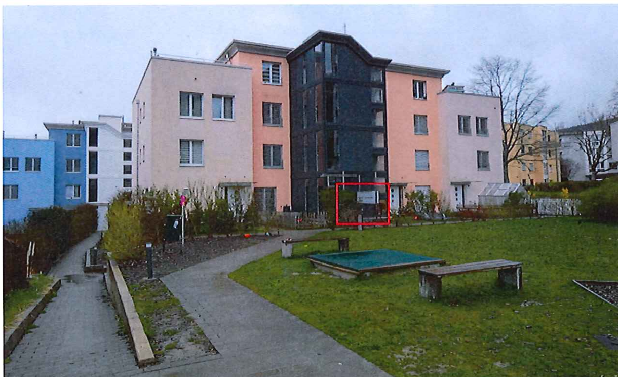
Vue de la façade Nord-Est
