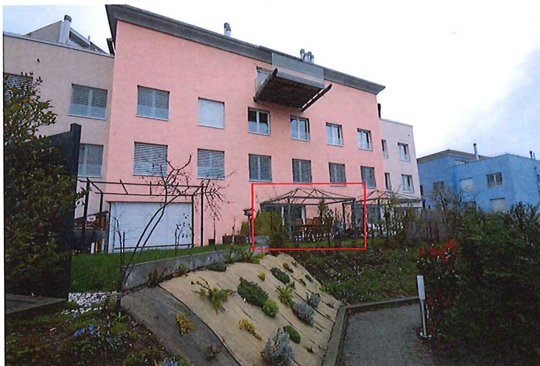
Vue de la façade Sud-Ouest
